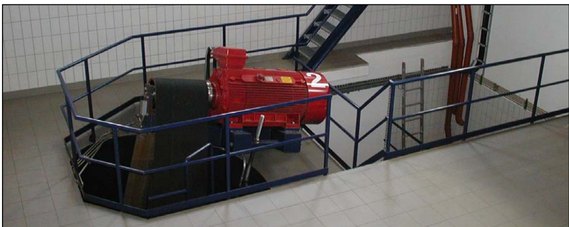
AD4-200 im Einsatz
