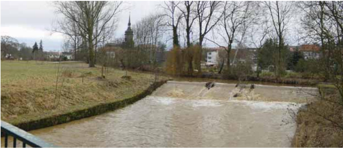
Wehr vor der Installation
