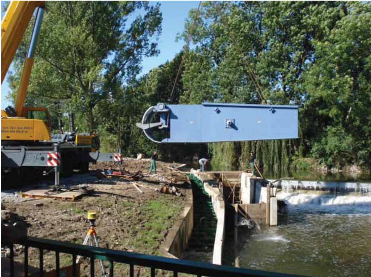
Anlieferung und Montage des beweglichen Krafthauses
