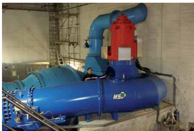
Maschine im Einsatz
