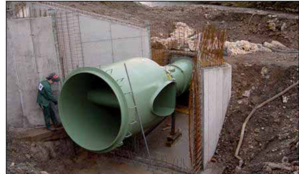
Einbau der Turbine
