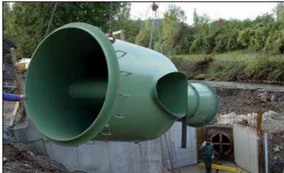
Einbau der Turbine
