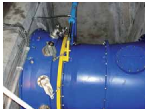
Maschine im Einsatz
