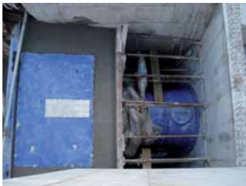
Einbetonieren der Turbine
