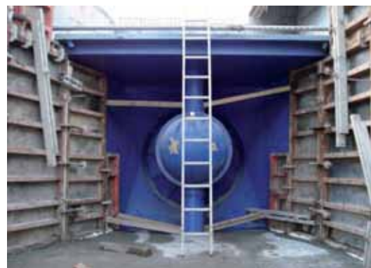
Einbetonieren der Turbine
