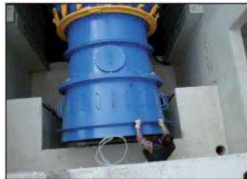
Einbau der Turbine
